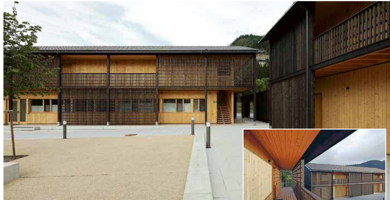
Der errichtete Holzriegelbau besteht komplett aus Fichte.
