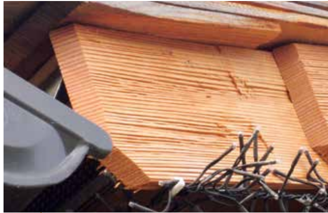
Lärchendacheindeckung mit Holzschindeln in RIFT-Machart – Garantie für Langlebigkeit.
