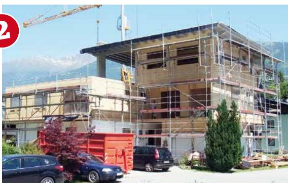
Dank der Bauweise mit vorgefertigten Holz-Wandelementen konnte die Rohbauphase innerhalb kurzer Zeit abgeschlossen werden
